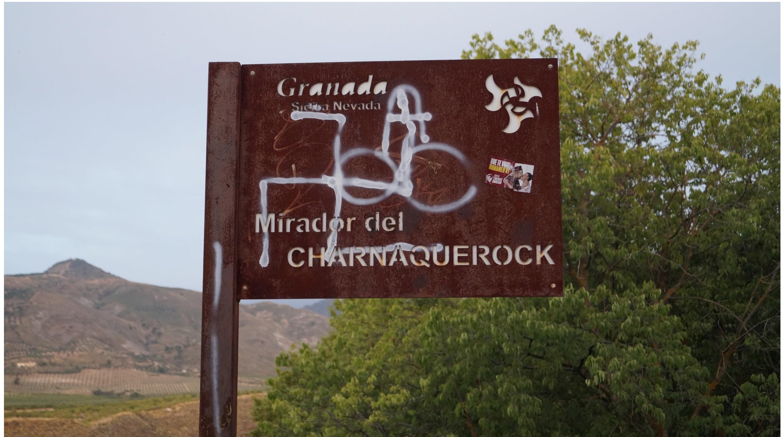
Fig. 58: cartel deteriorado. Acequia Baja
