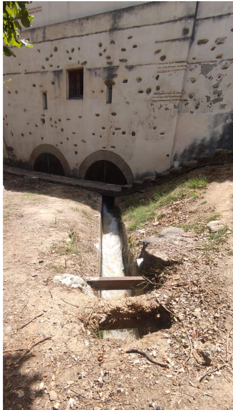
Fig. 25: boca de túnel del molino Batán. Acequia Baja. Coordenadas: desde 37°04'01.46"N, 3°34'42.57"O hasta 37°04'00.80"N 3°34'41.65"O
