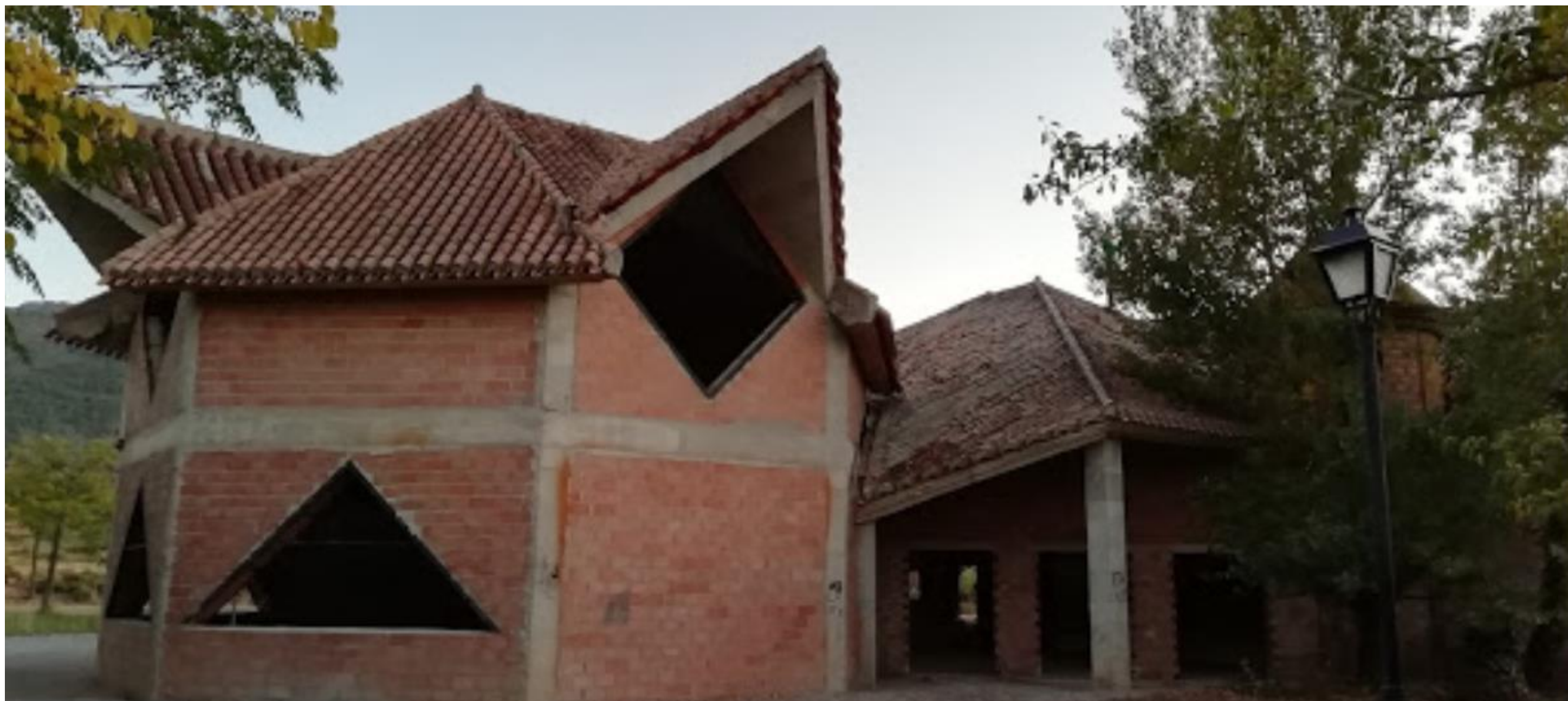
Fig. 63: edificio a media construcción en el Parque de la Ermita en Av. Emiloo Muñoz 56, Dílar. Imagen recuperada de GoogleMaps.
