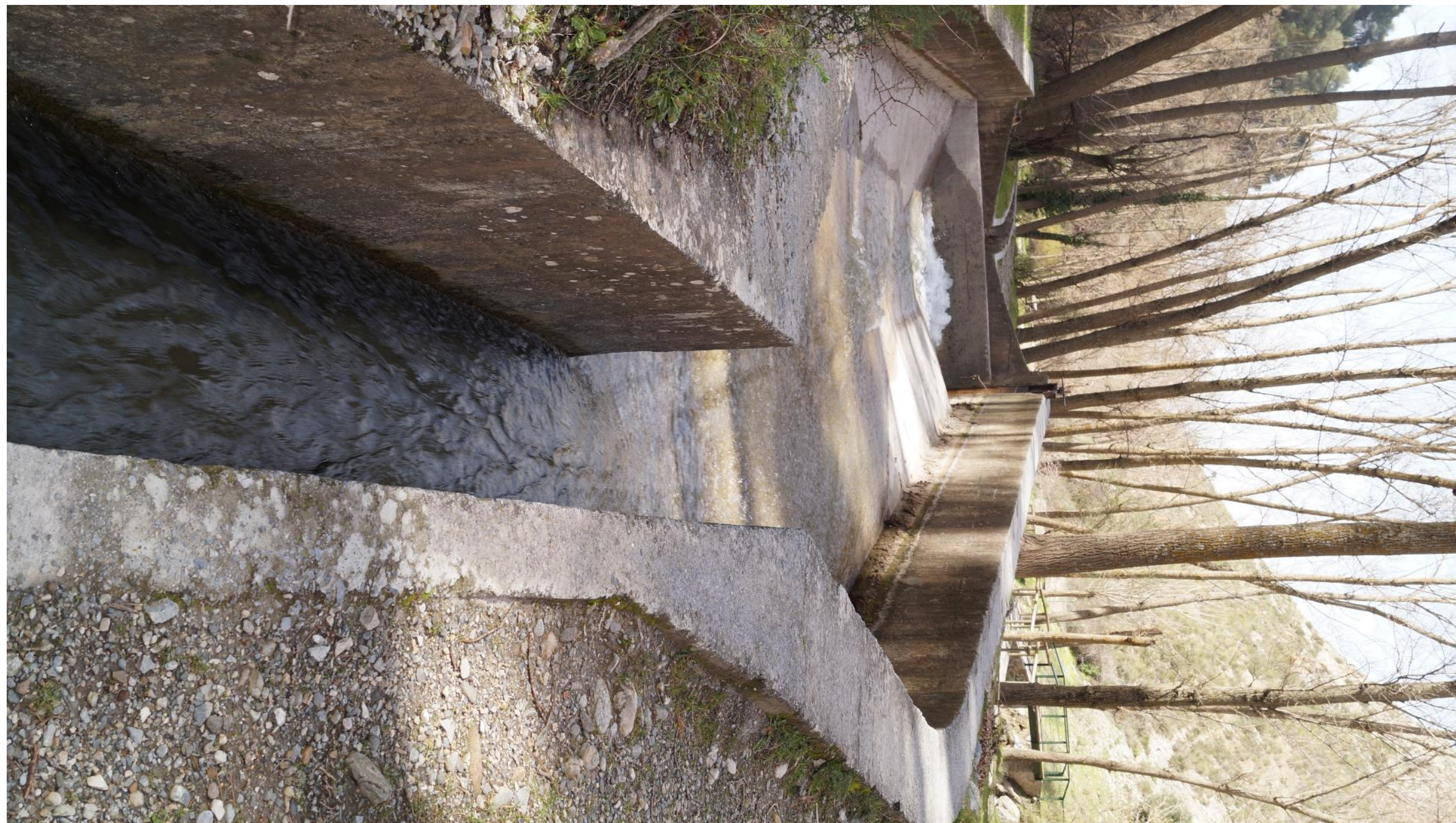
Fig. 16: desarenador de la acequia Alta. Umbría de la Chata.
