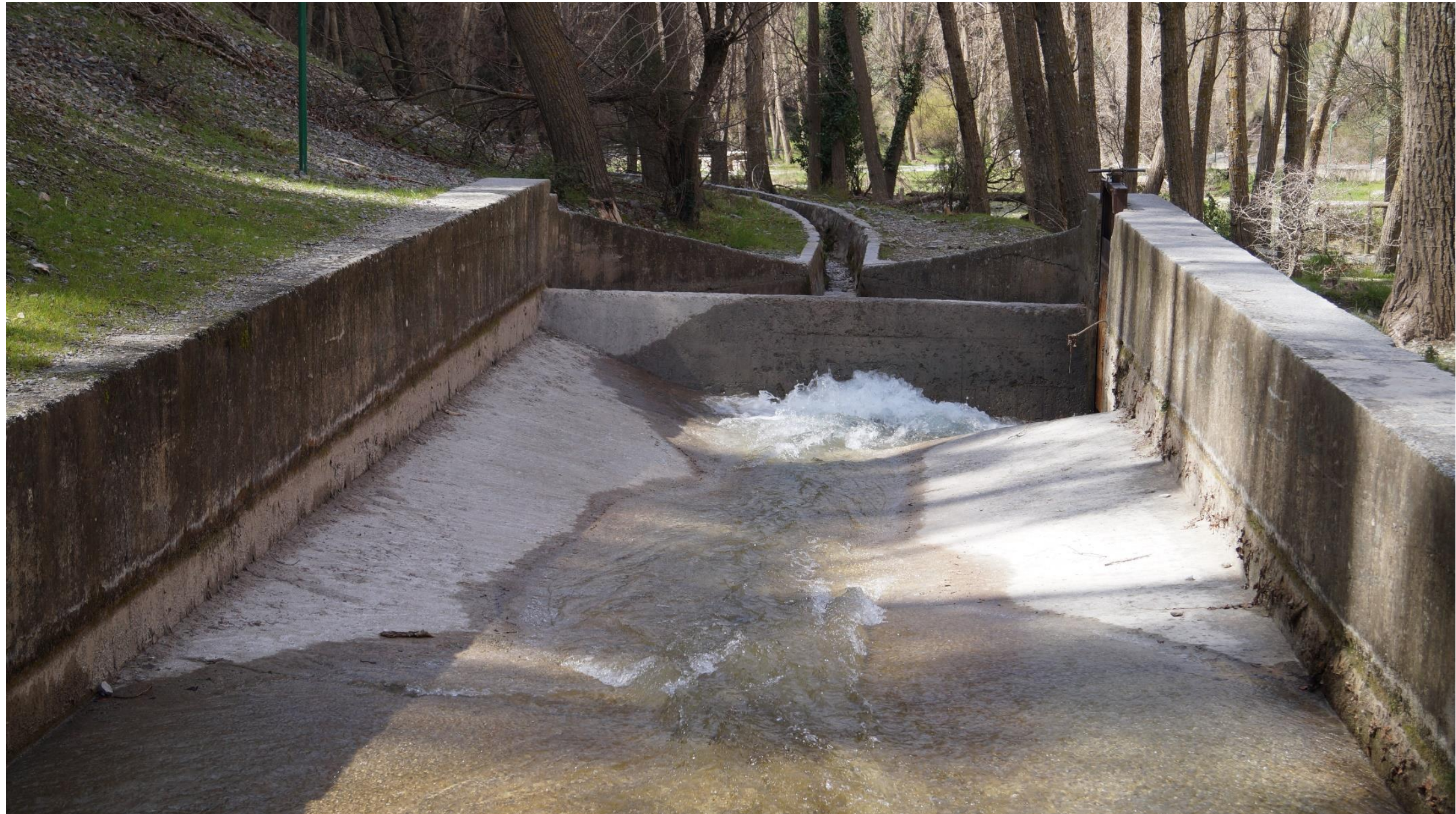
Fig. 17: desarenador de la acequia Alta. Umbría de la Chata.
