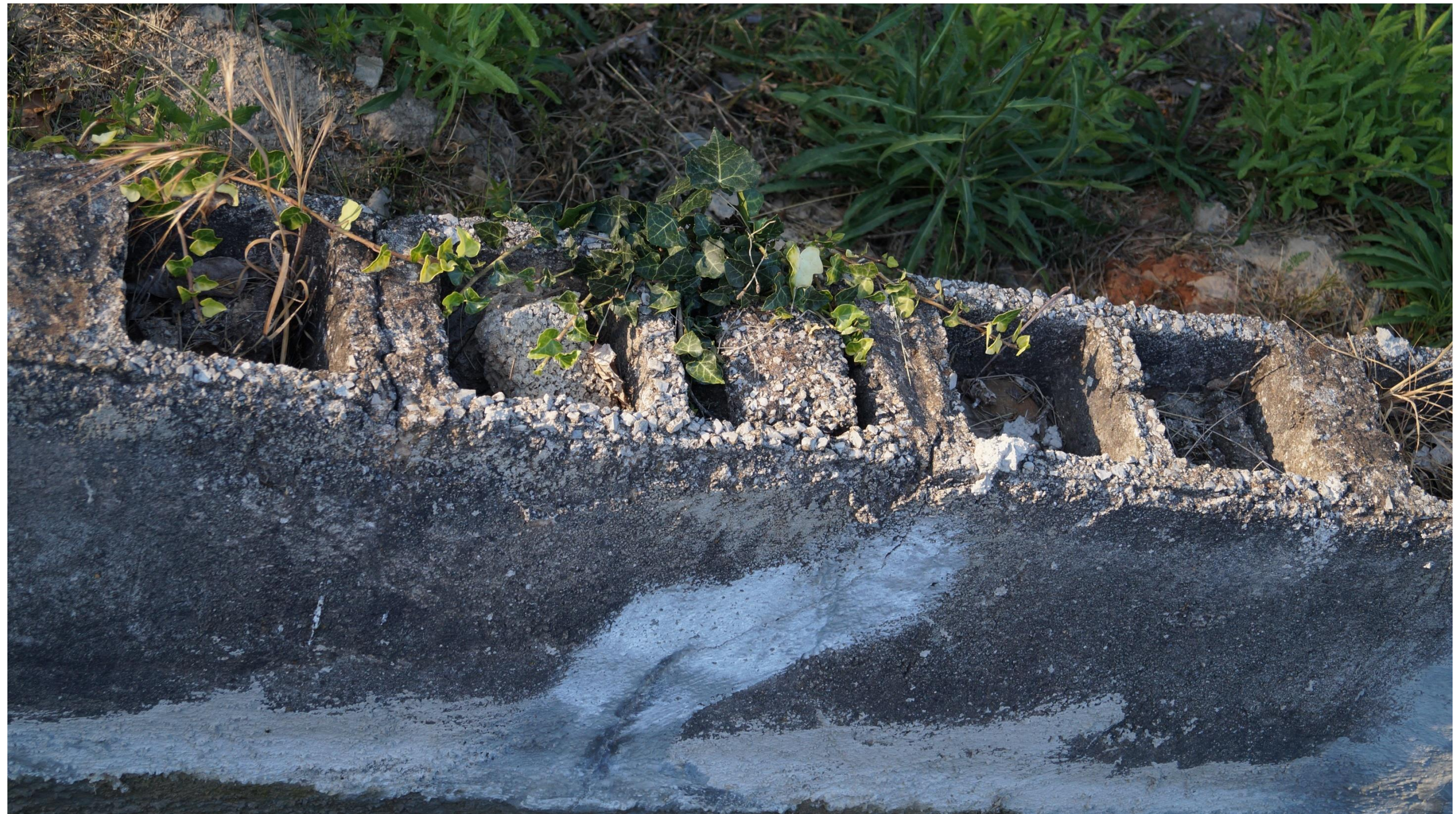
Fig. 57: bloques de hormigón en tramo de La Hoya poco integrados en el conjunto.
