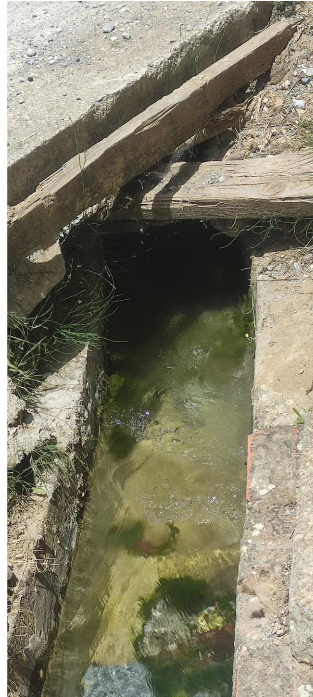
Fig. 26: boca de túnel que cruza camino hacia la ctra. de la fábrica. Coordenadas: desde 37°04'08.80"N, 3°34'59.63"O
