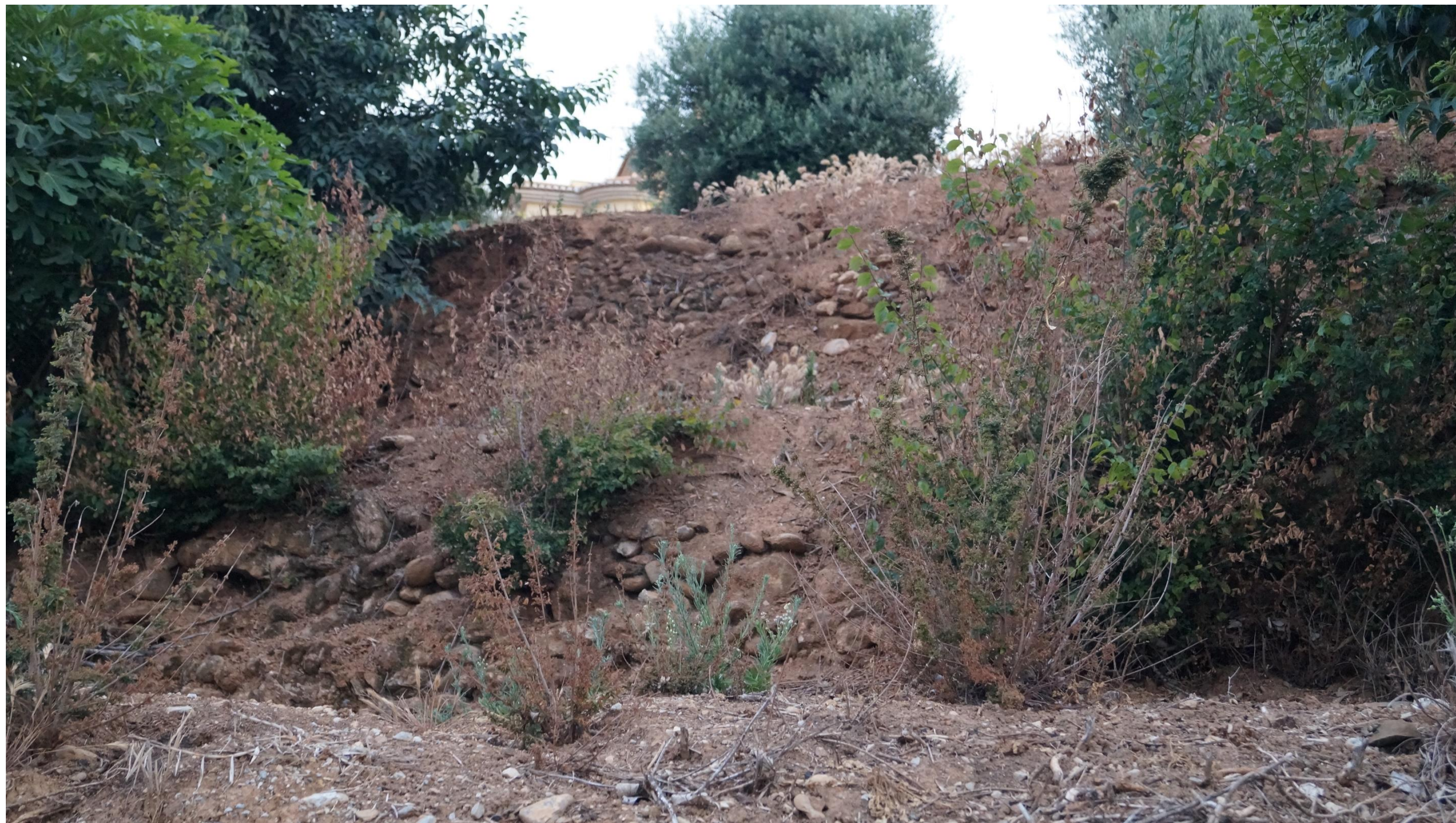
Fig. 3: balate de piedras y tierra del mismo terreno
