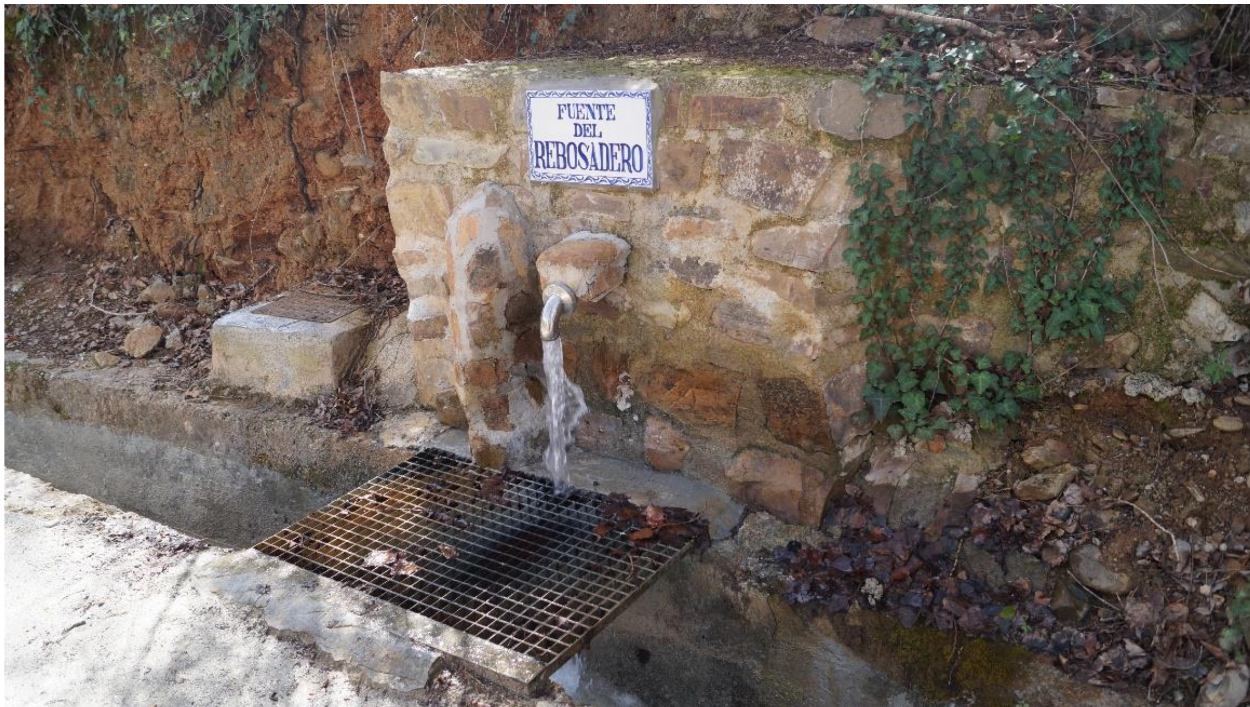
Fig. 32: fuente del Rebosadero. Acequia Alta. Coordenadas 37°04'02.6"N, 3°35'12.4"W Grado de afectación 0%
