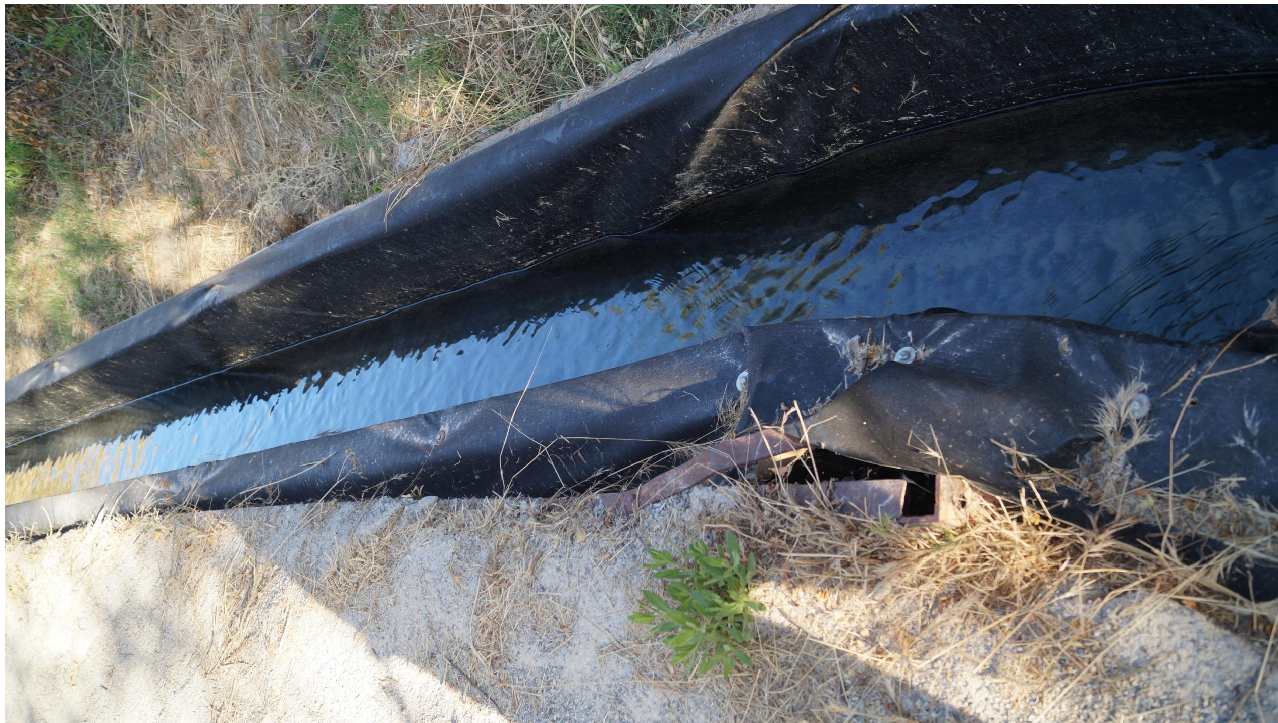
Fig. 49: elementos metálicos sobresalientes en pago de La Hoya
