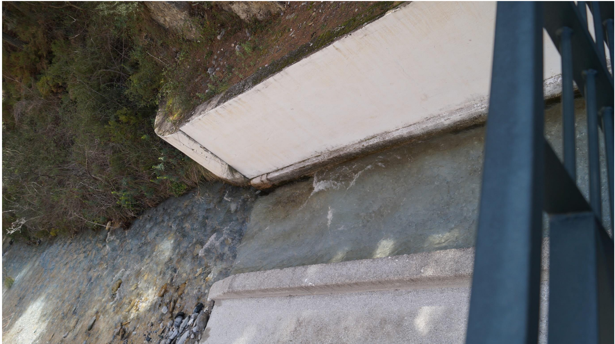
Fig. 14: estación de aforo de la acequia Alta. Umbría de la Chata.
