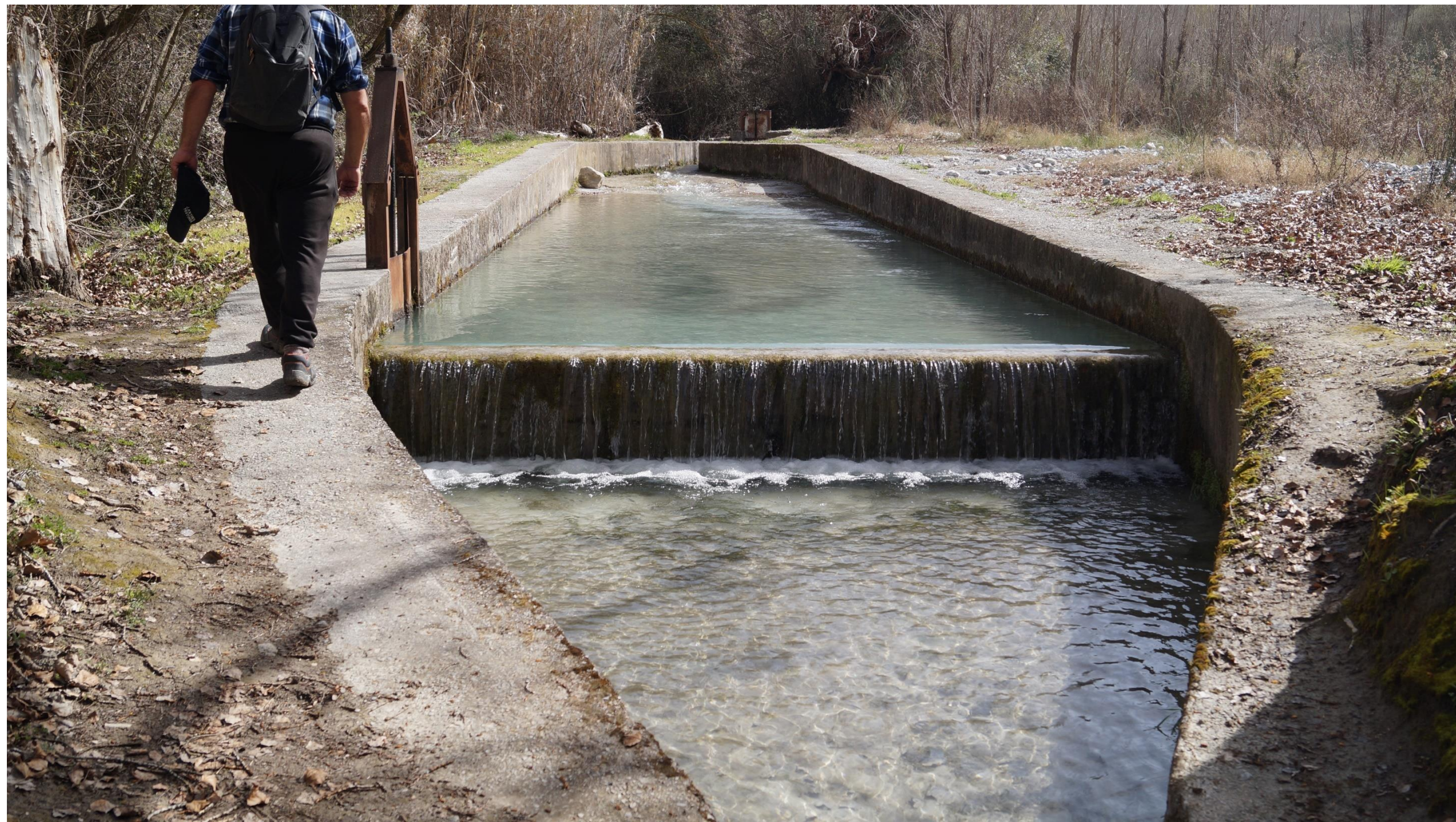
Fig. 18: desarenador de la acequia Baja Coordenadas: 37° 3'50.92"N 3°33'51.18"O Grado de afectación 0%
