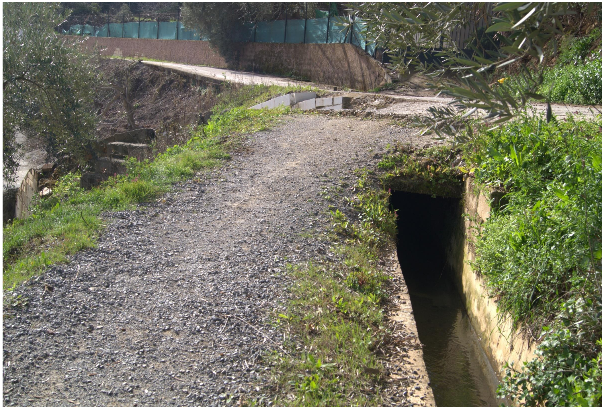
Fig. 51: carretera de reciente fabricación en acequia Baja que deja el trazado soterrado.
