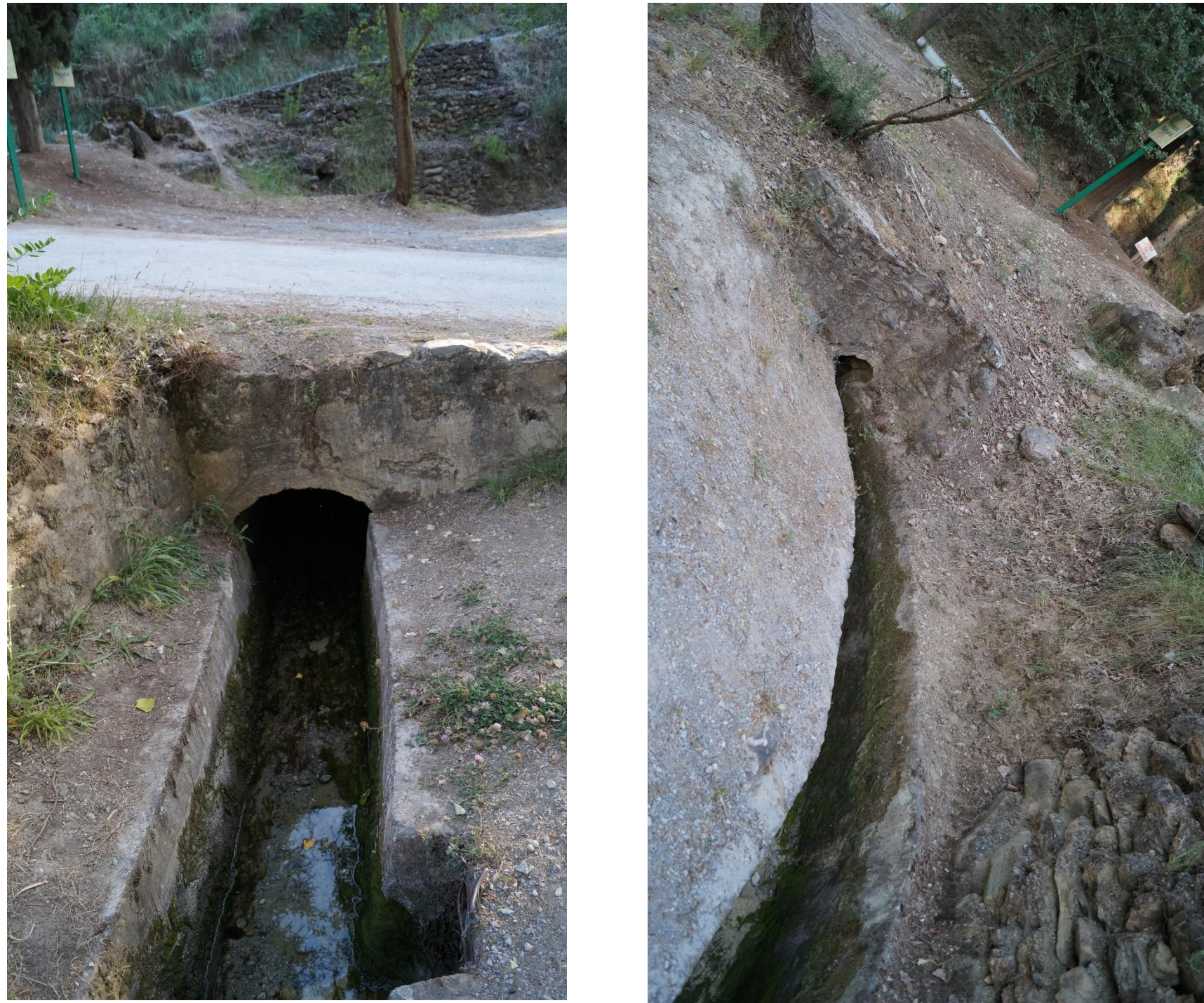
Fig. 23: bocas de túnel en acequia Alta. Después del Parking límite con Parque Natural Coordenadas: desde 37°03'46.24"N, 3°33'32.13"O hasta 37°03'46.28"N, 3°33'32.30"O Grado de afectación: 0%
