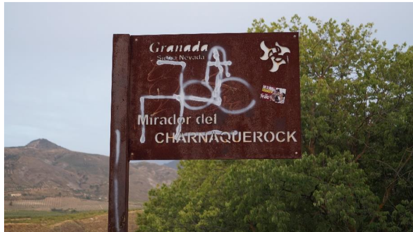
Fig. 58: deterioro de señales por vandalismo
