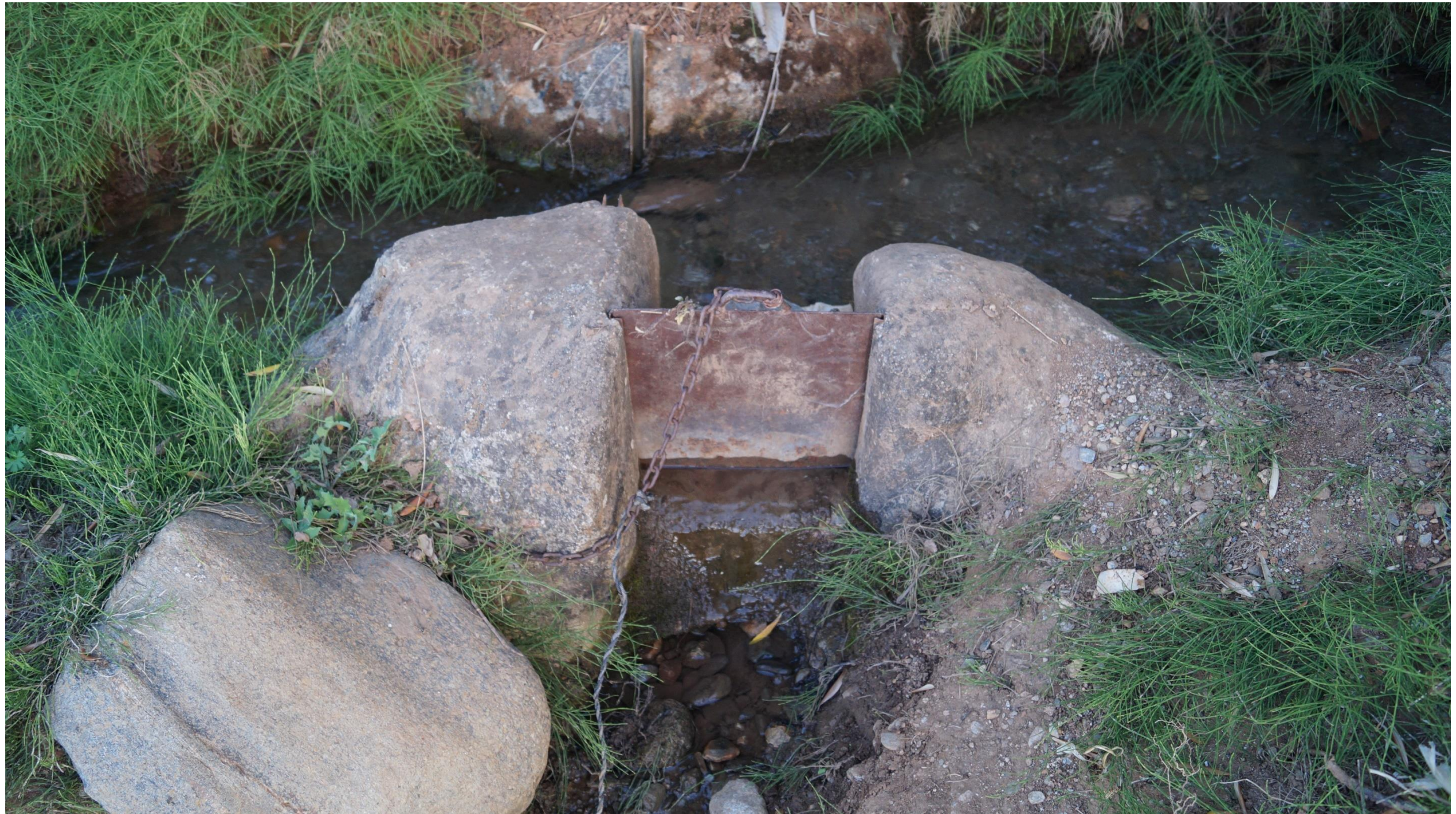
Fig. 4: Compuerta metálica en jambas de piedra con ranuras en chorro.
