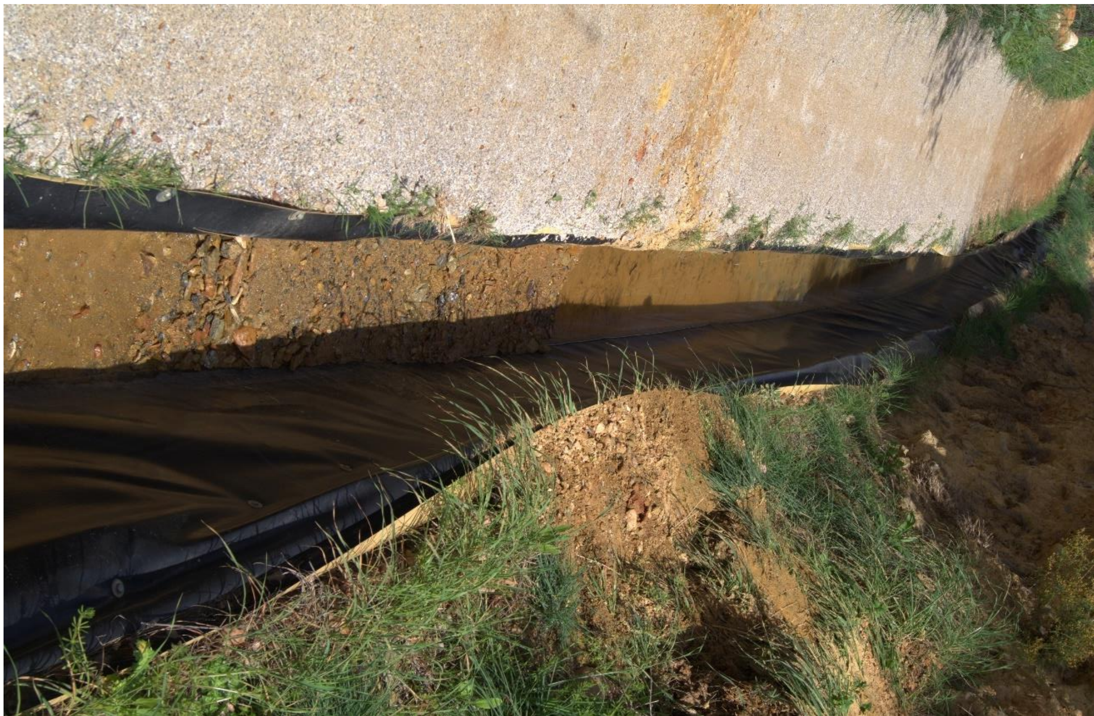
Fig. 56: tela asfáltica en tramo de La Hoya
