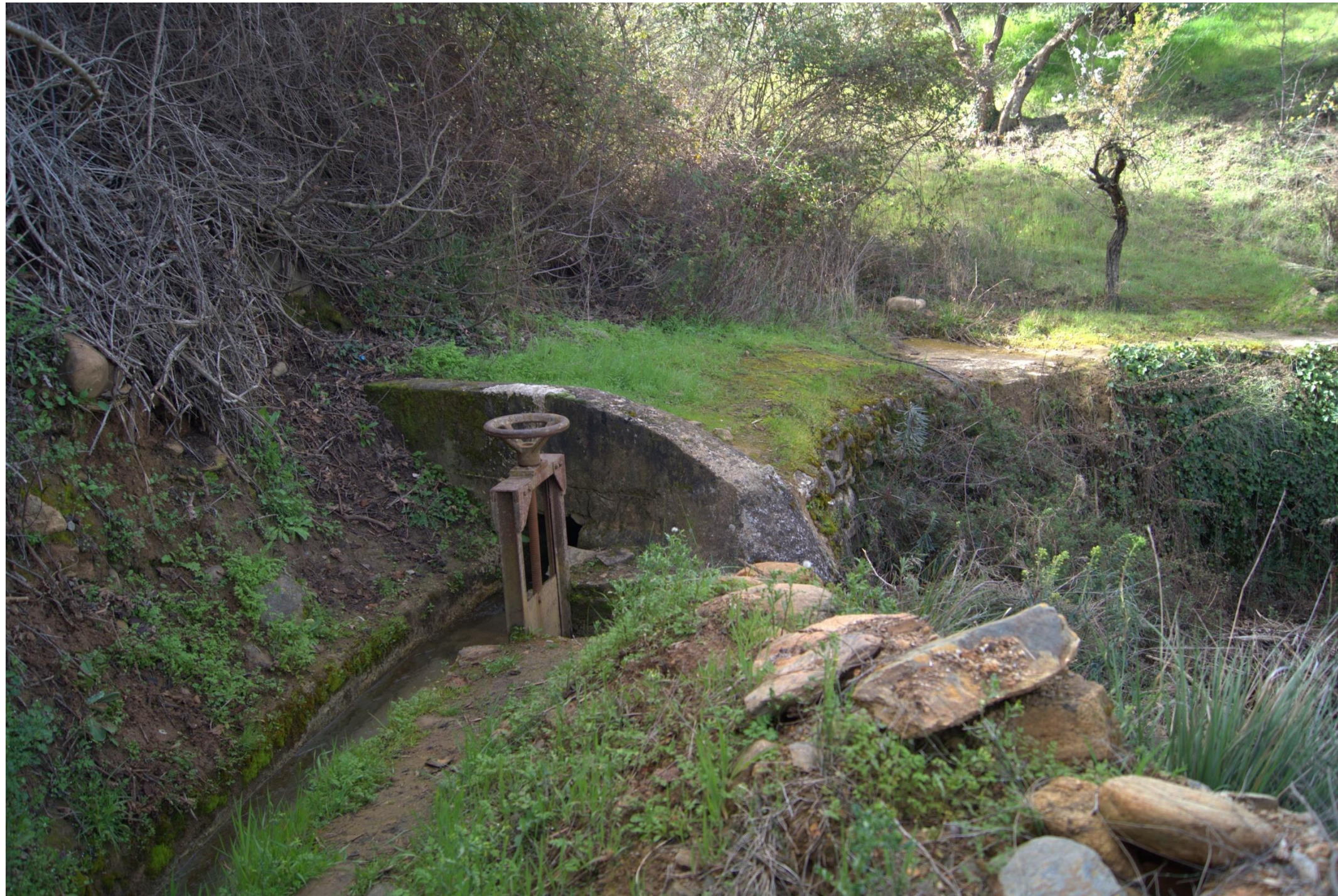
Fig. 20: aliviadero en la acequia Baja con compuerta de volante.
