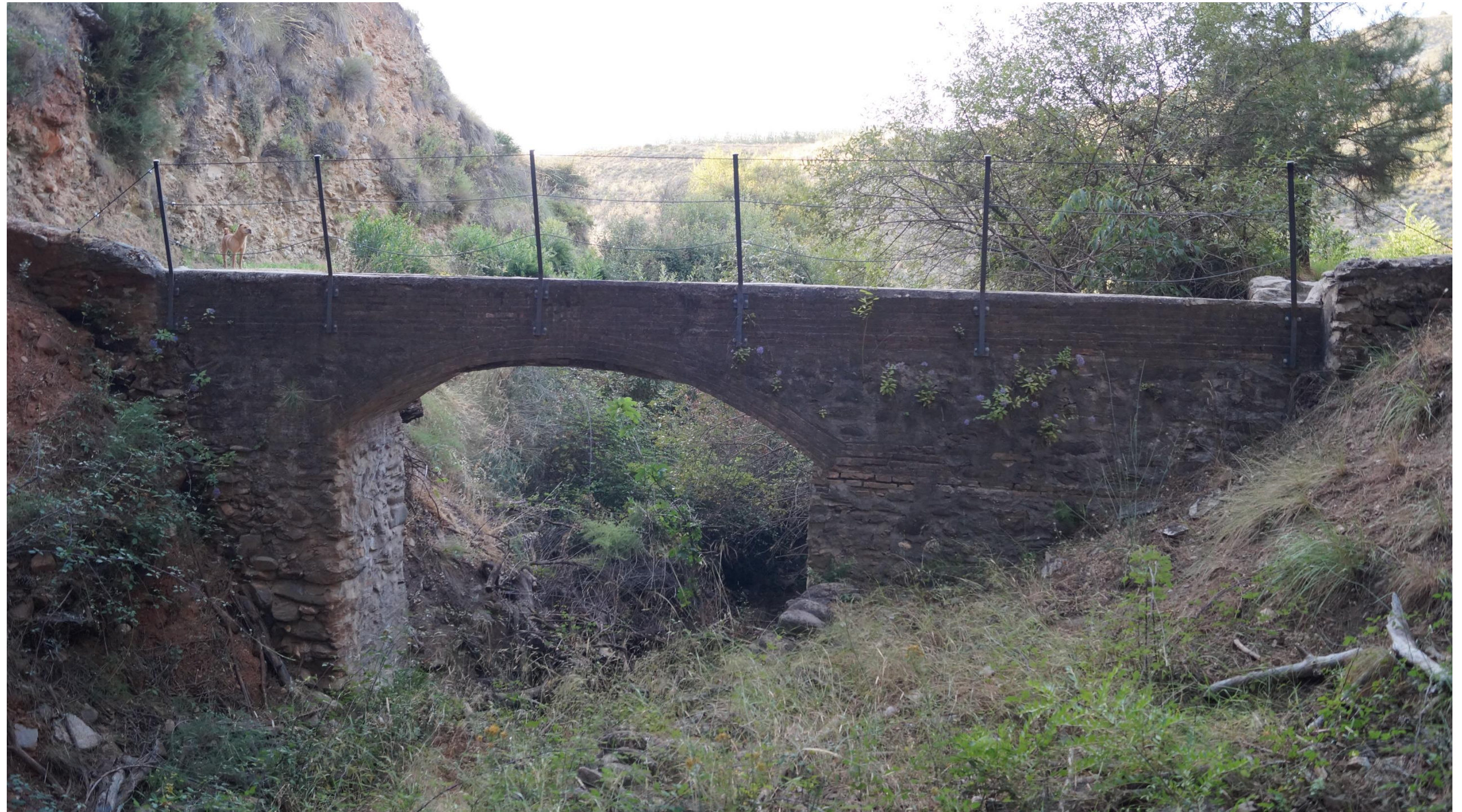
Fig.28: acueducto en la acequia Alta
